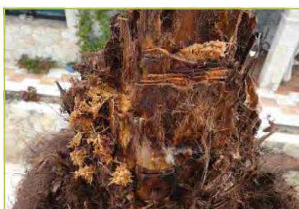
Dégâts & amas de sciure
